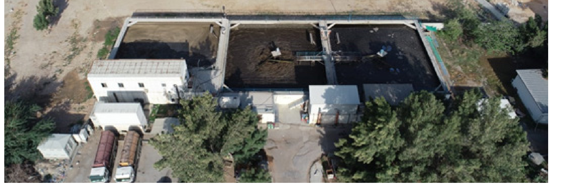
الشكل ٣: مرفق تصريف مياه الصرف الصحي لشركة الحمراء للتطوير العقاري
